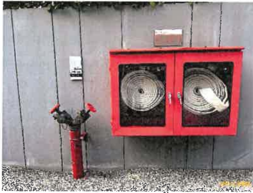
ตู้เก็บสายฉีดน้ำดับเพลิงพร้อมอุปกรณ์ (Fire Hose Cabinet : FHC)
